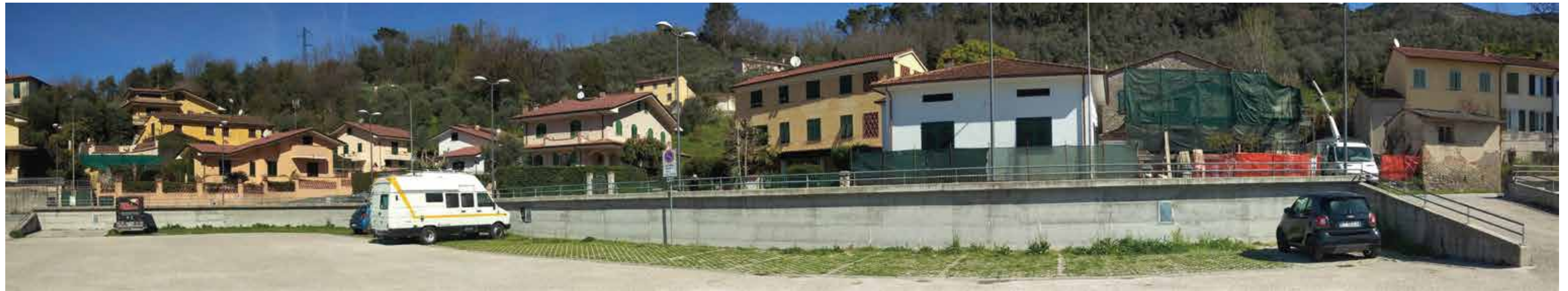
SUPERFICIE DEL MURO PERIMETRALE DISPONIBILE PER L'INTERVENTO.
